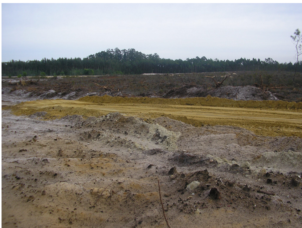
Foto 8 - Vista da Mancha de Empréstimo do Montalvo (Vista O/E).
