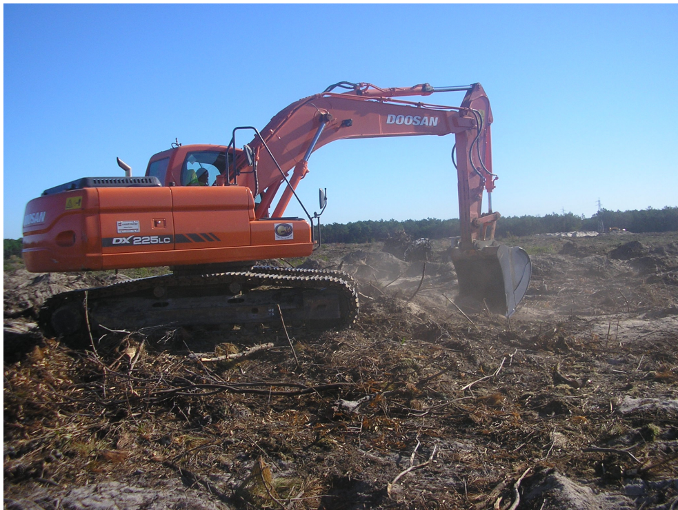
Foto 1 – Desmatção na zona onde se situará a plataforma de trabalho para o poço de captação 1 (Vista O/E).
