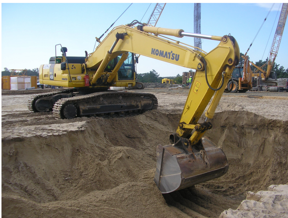
Foto 9 - Escavação de área para o decantador 1 (Vista NE/SO).
