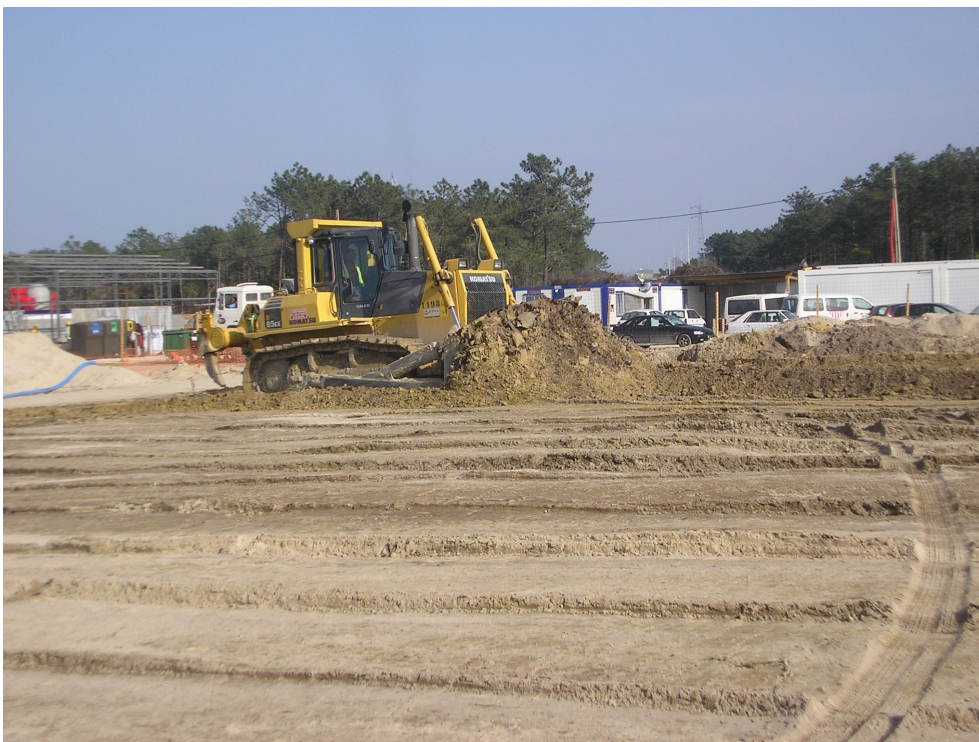
Foto 13 - Aterro na zona dos tanques (Vista O-SO/E-NE).
