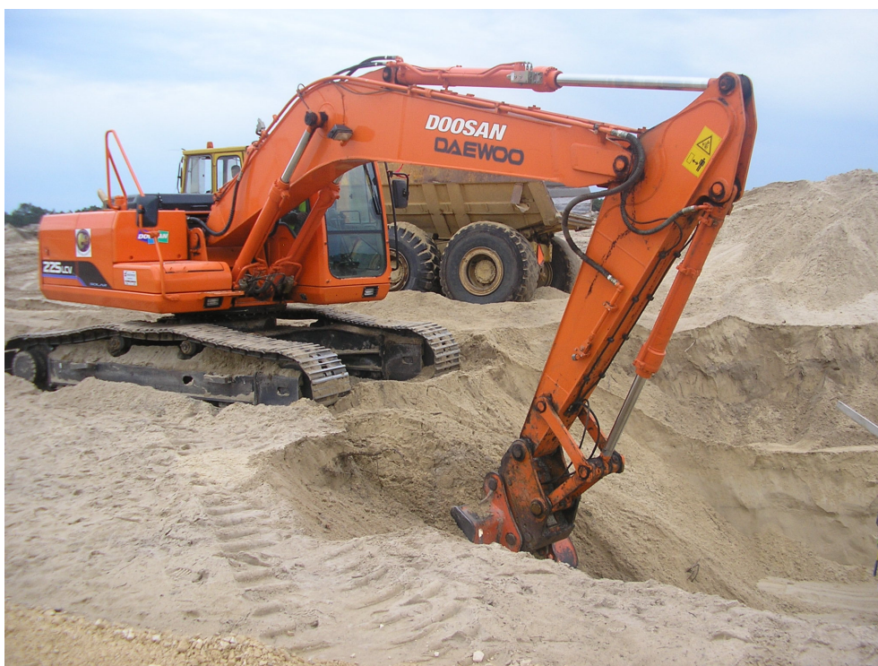
Foto 7 - Escavação de vala para o canal Este (Vista E-NE/O-SO).
