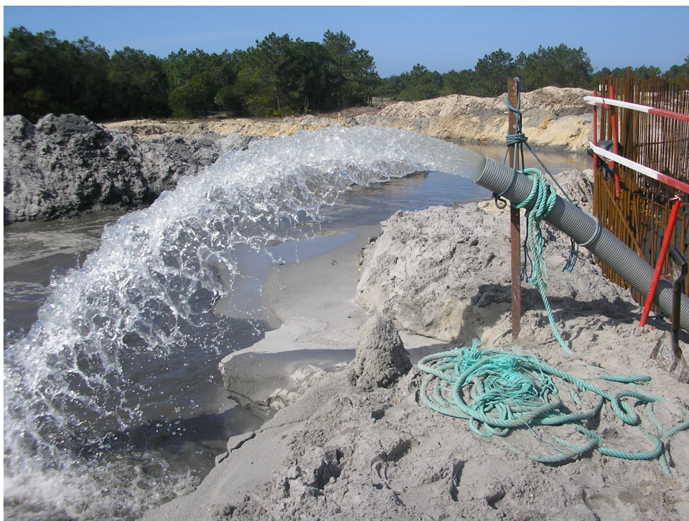
Foto 16 - Vista da dragagem do poço de captação 1 (Vista SE/NO).
