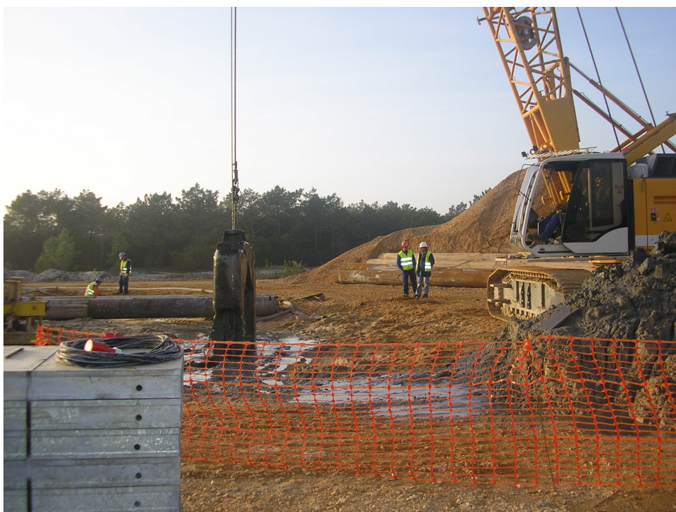
Foto 6 - Perfuração nas paredes moldadas do poço de captação 1 (Vista SE/NO).
