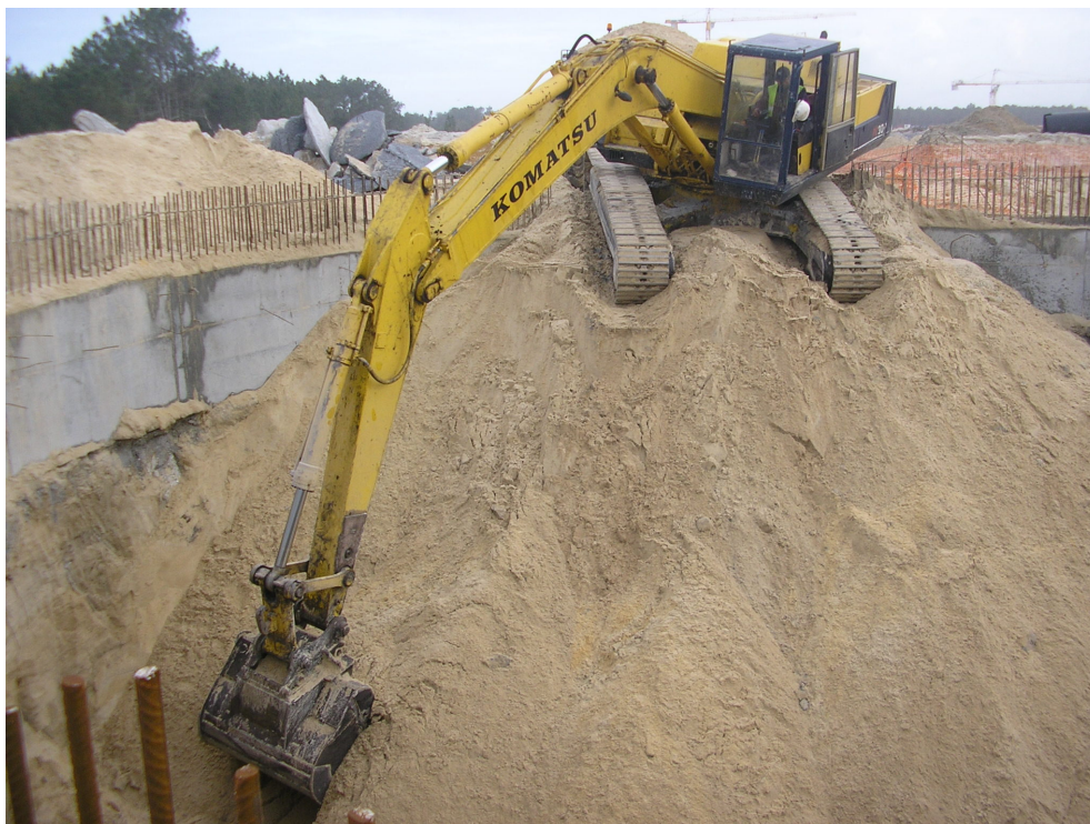
Foto 15 - Escavação no poço de descarga 1 (Vista S-SO/N-NE).
