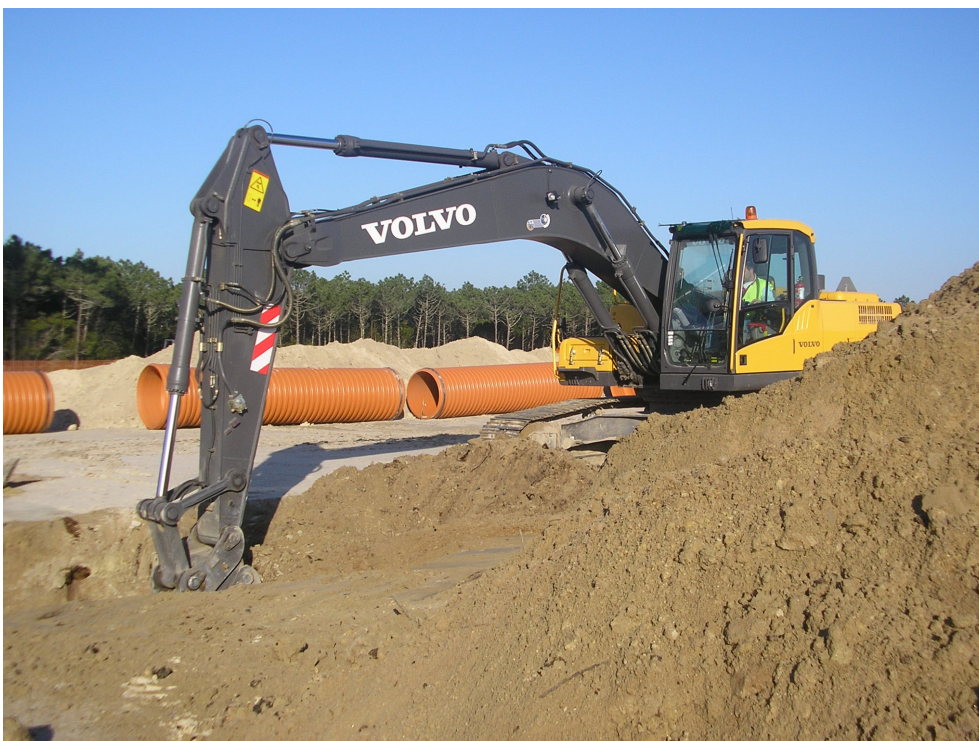
Foto 12 - Escavação de vala de esvaziamento (Vista SO/NE).
