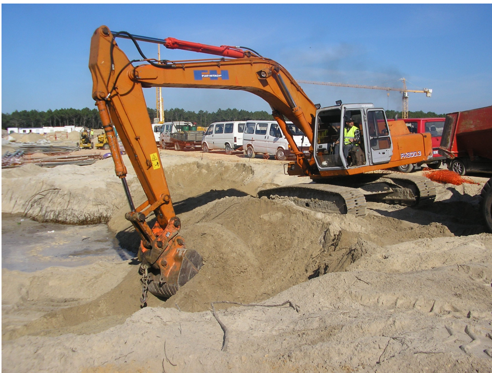
Foto 11 - Escavação no poço de oxigenação 1 (Vista S/N).
