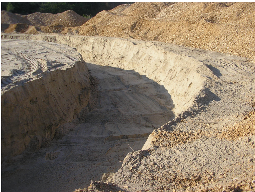
Foto 5 - Vista da vala de fundação para o muro guia do poço de captação 1 (Vista E/O).
