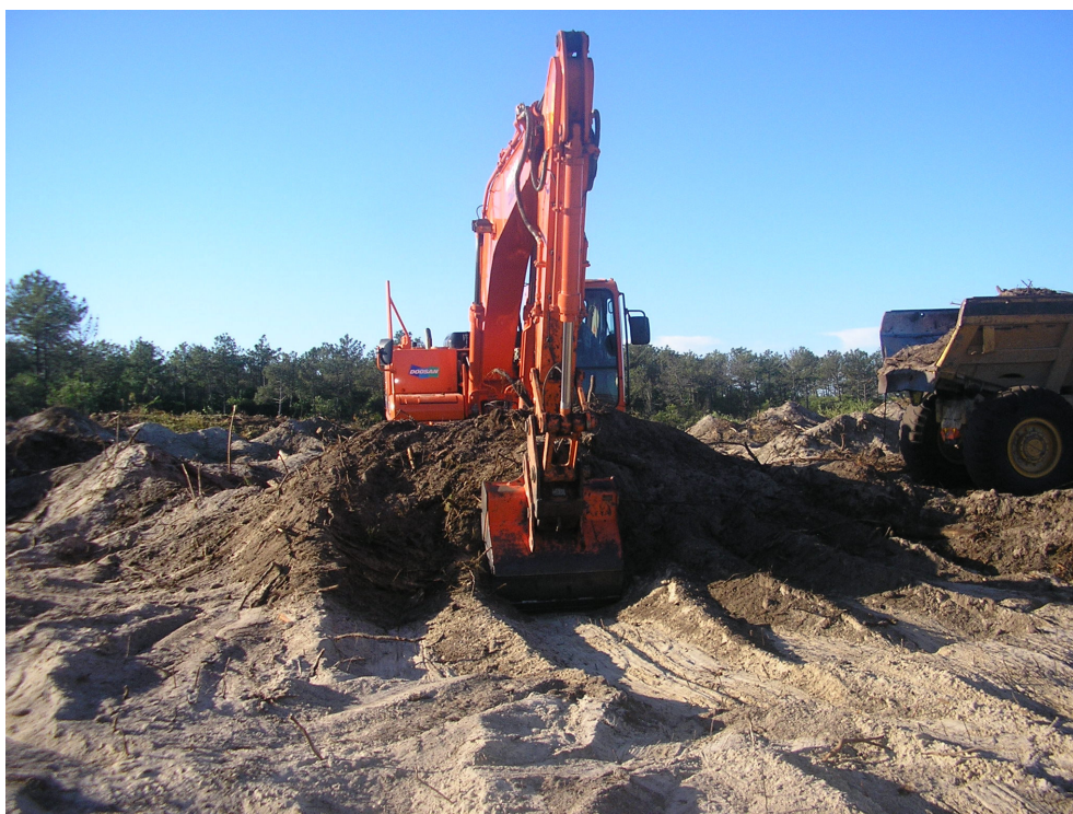
Foto 4 – Desmatção / decapagem na plataforma para a fábrica de tubos (Vista N/S).
