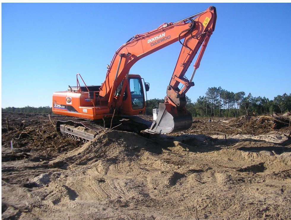
Foto 3 – Desmatção / decapagem a Oeste do PK 0+220 do Eixo 3 (Vista NE/SO).
